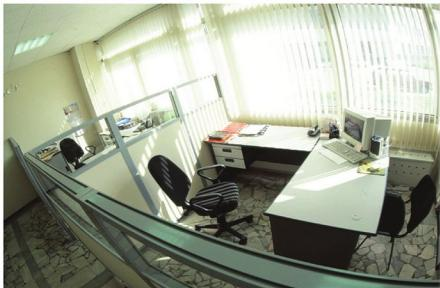
Металлопластиковые офисные перегородки изготавливаются из ПВХ-профиля, аналогичному тому, который используется для изготовления пластиковых окон. Пластиковые офисные перегородки, так же, как и окна ПВХ, обладают хорошими звукоизоляционными качествами. Для звукоизоляции рекомендуется устанавливать металлопластиковые перегородки высотой до потолка.
